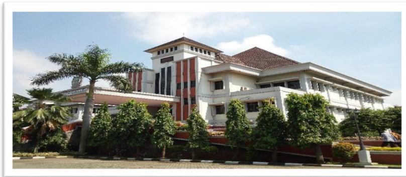
GAMBAR 3.2 GEDUNG DPRD KOTA BEKASI JL. CHAIRIL ANWAR
