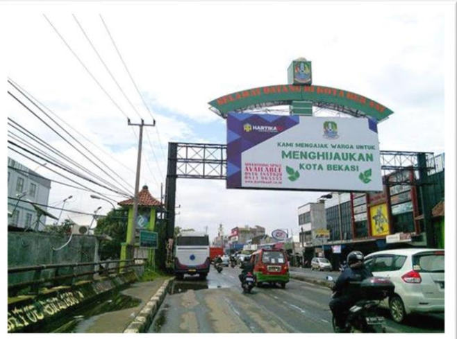
Pintu Gerbang Masuk Kota Bekasi
